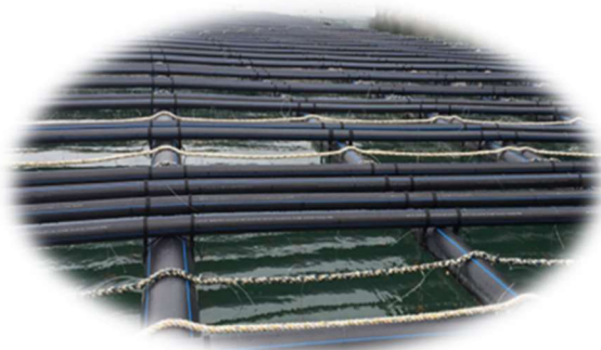
Hệ thống nuôi hàu bằng ống HDPE
